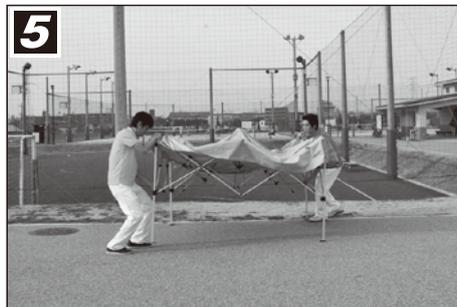
対角になる柱箇所のトラスバー下側と OUTER LEG 上部を持ち上げながら、さらに外側へ引っ張り、本体フレームを最大まで広げます。
